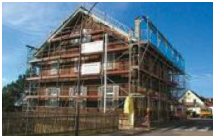
Renovierung des Alten Schulhauses
